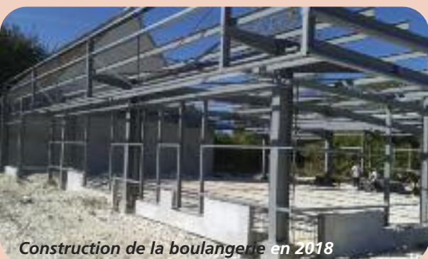
Construction de la boulangerie en 2018
